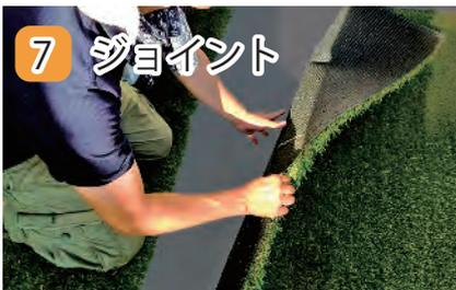
両側の人工芝をつきあわせ、重ならないか、間隔が開いていないか、ジョイントラインが曲がっていないか確認します（この際、ジョイント部分を接着剤で防草シートに固定したり、ジョイントテープで貼り合わせるとより強固になります）
