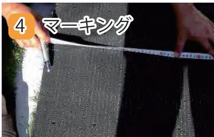
設置場所の長さ、アール部分(曲線部分)や構造物等に合わせて、裁断部分にチョーク等で印を付けます。
