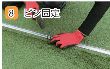
人工芝用固定ピンで固定します。縫い目方向と平行になるよう、またパイルを巻き込まないように打ち込みます（固定間隔は、人工芝の周囲を50cm間隔）。ジョイント部分は2枚の人工芝をまたぐように打ち込みます。
