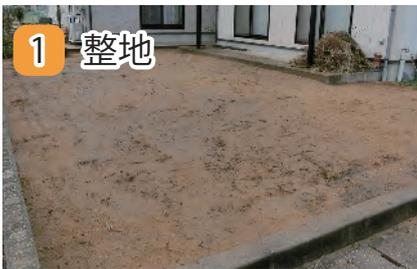
雑草や石などを取り除きます。平らに均し、転圧し地盤を固めます。地盤の凸凹を無くすことが、仕上がりを美しくするポイントです。（水はけが悪い場合、砂を入れるなどして路盤処理をします。）
