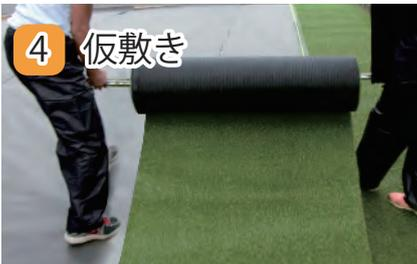
人工芝をたるみのないよう広げ、仮敷きします。芝目（芝の寝ている方向）が揃うよう、必ず1方向に展開します。
