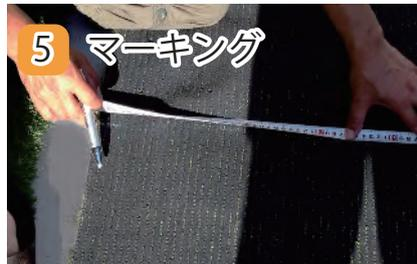
設置場所の長さ、アール部分（曲線部分）や構造物等に合わせ、裁断部分にチョーク等で印を付けます。
