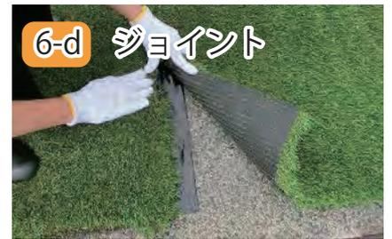
もう一枚の人工芝を貼り合わせます。接着後、ジョイント部分を転圧し、圧着させます。
