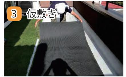
人工芝をたるみのないよう広げ、仮敷きします。芝目(芝の寝ている方向)が揃うよう、必ず1方向に展開します。(写真では、後のカットのため裏返して広げています)
