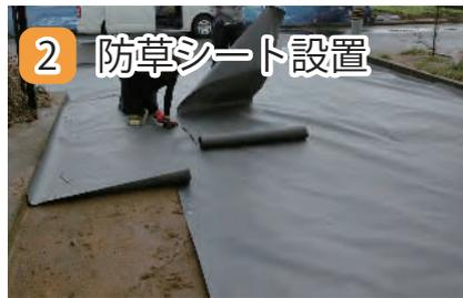
防草シートを設置します。防草シートを広げ、防草シート用固定ピンで固定します。（固定間隔は、シートの周囲を約50～100cm間隔）。シートの重ね部分は約5～10cmほど重ねます。
